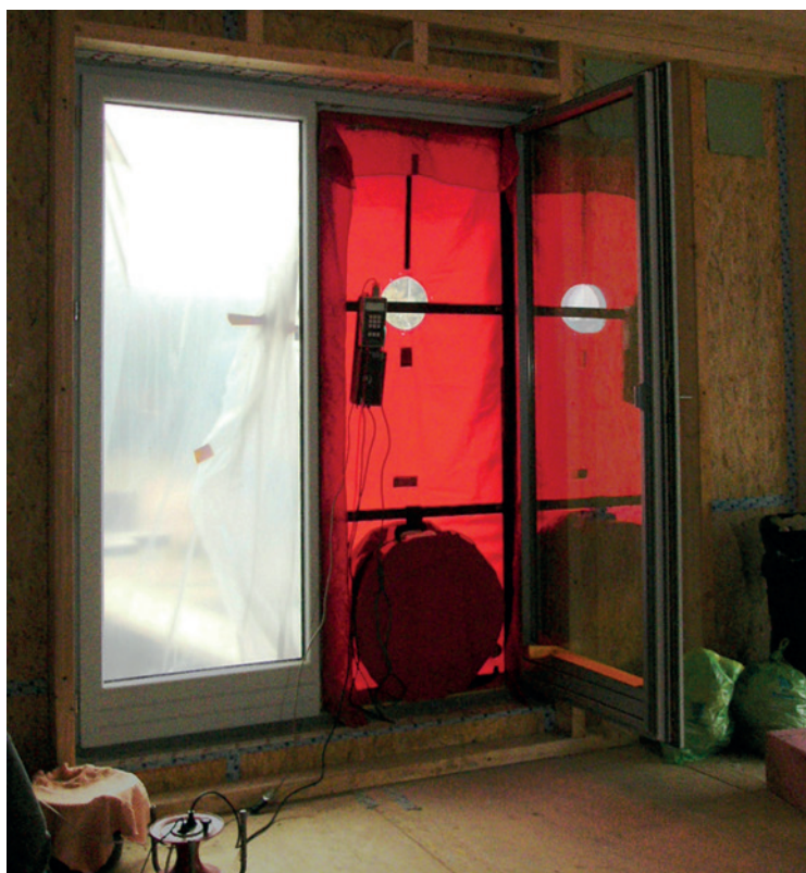
Blower-door test hrubej stavby drevostavby v praxi foto: autor
